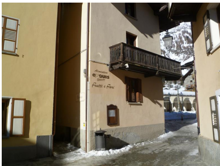
Restringimento di piazza Umberto I che da accesso all'area di cantiere, passaggio clempo
