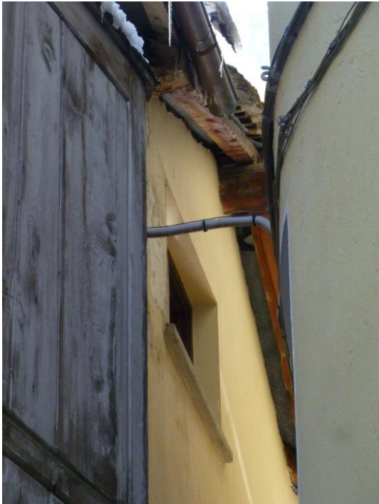
Linee sul prospetto Sud Est
