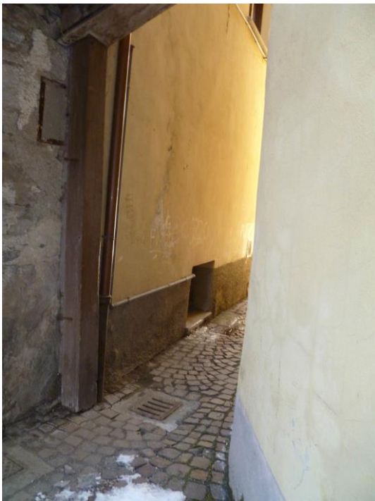
Linee sul prospetto Sud Est
