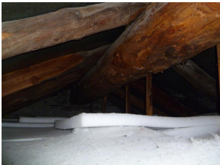
Particolare struttura tetto
