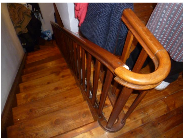
Particolare scala interna
