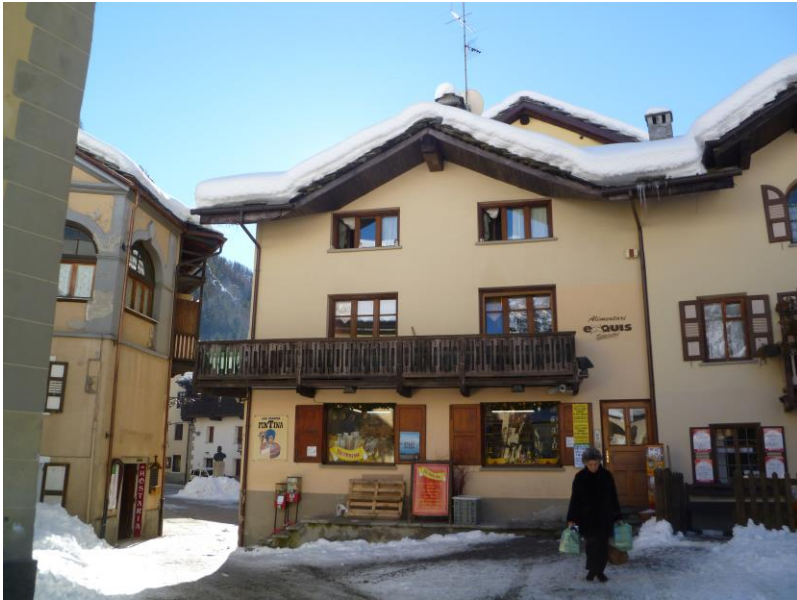
Ingresso del fabbricato su via piazza della chiesa
