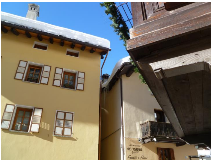
Linee sul prospetto sud est
