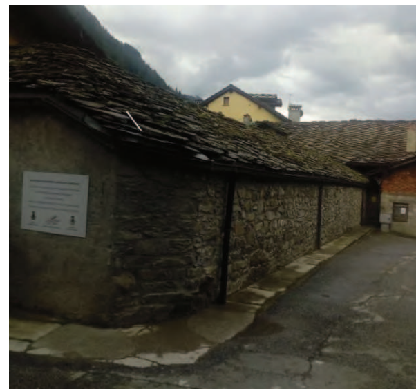
Prospetto esterno ad Ovest
