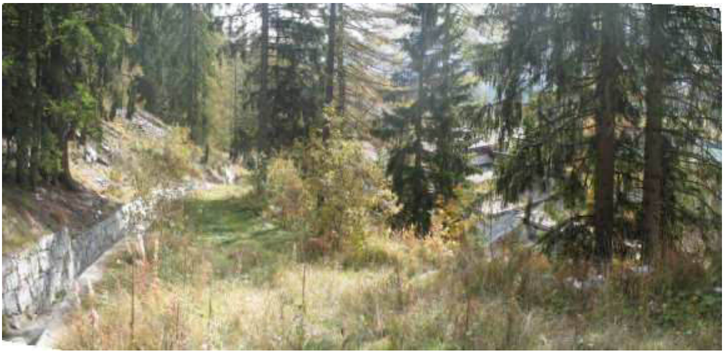
Foto 3: il tratto di alveo dell'Hobeergbach incanalato a monte del Palazzetto dello Sport.
