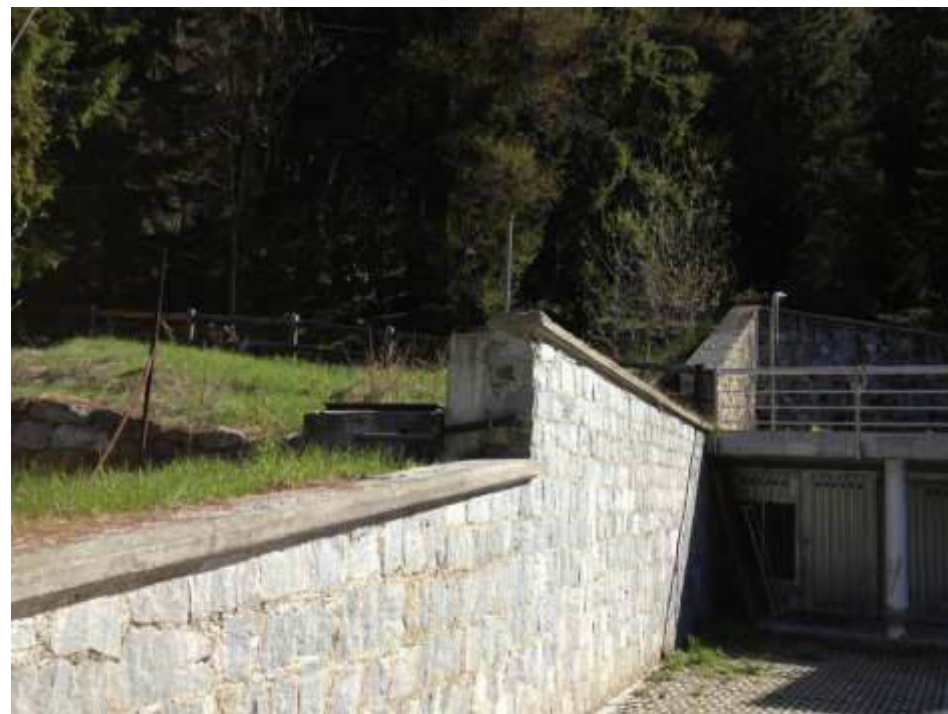
Foto 6: panoramica da nord del Palazzetto, dove è prevista la realizzazione della nuova centrale termica. Si noti sulla sinistra la spalletta costituita dalla parte alta del muro di controripa che protegge la struttura da eventuali flussi di ruscellamento da monte.
