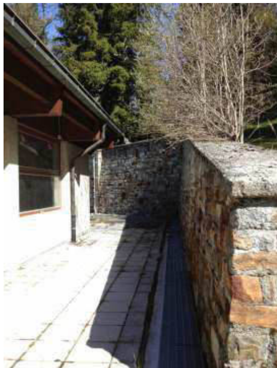
Foto 6: panoramica da nord del Palazzetto, dove è prevista la realizzazione della nuova centrale termica. Si noti sulla sinistra la spalletta costituita dalla parte alta del muro di controripa che protegge la struttura da eventuali flussi di ruscellamento da monte.
