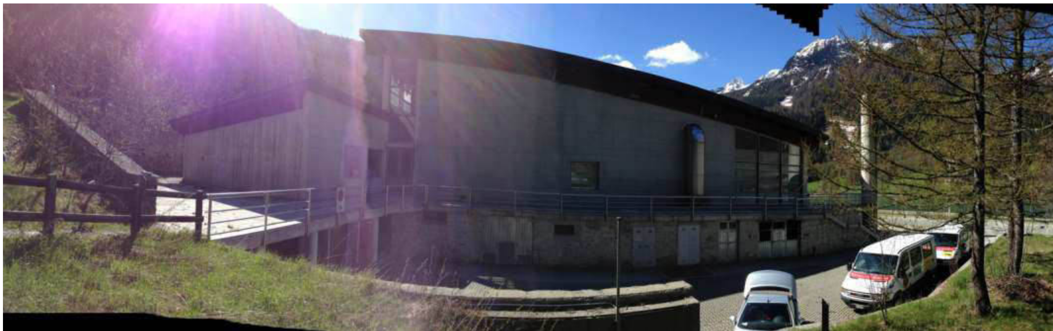
Foto 6: panoramica da nord del Palazzetto, dove è prevista la realizzazione della nuova centrale termica. Si noti sulla sinistra la spalletta costituita dalla parte alta del muro di controripa che protegge la struttura da eventuali flussi di ruscellamento da monte.
