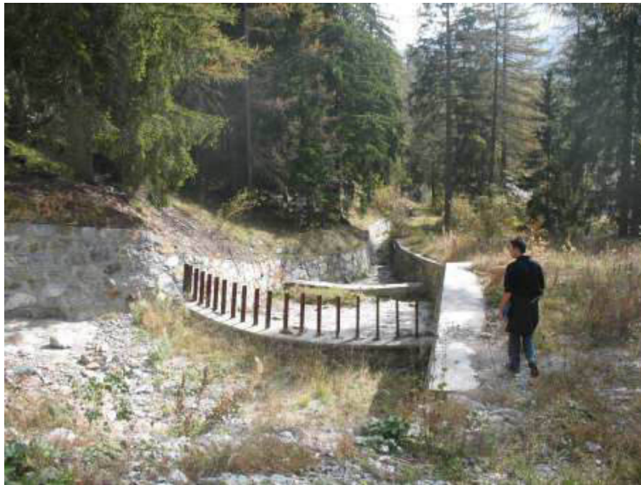
Foto 4-5: la briglia a monte del tratto canalizzato e il settore finale di confluenza nell'Horobach a sud del Palazzetto.
